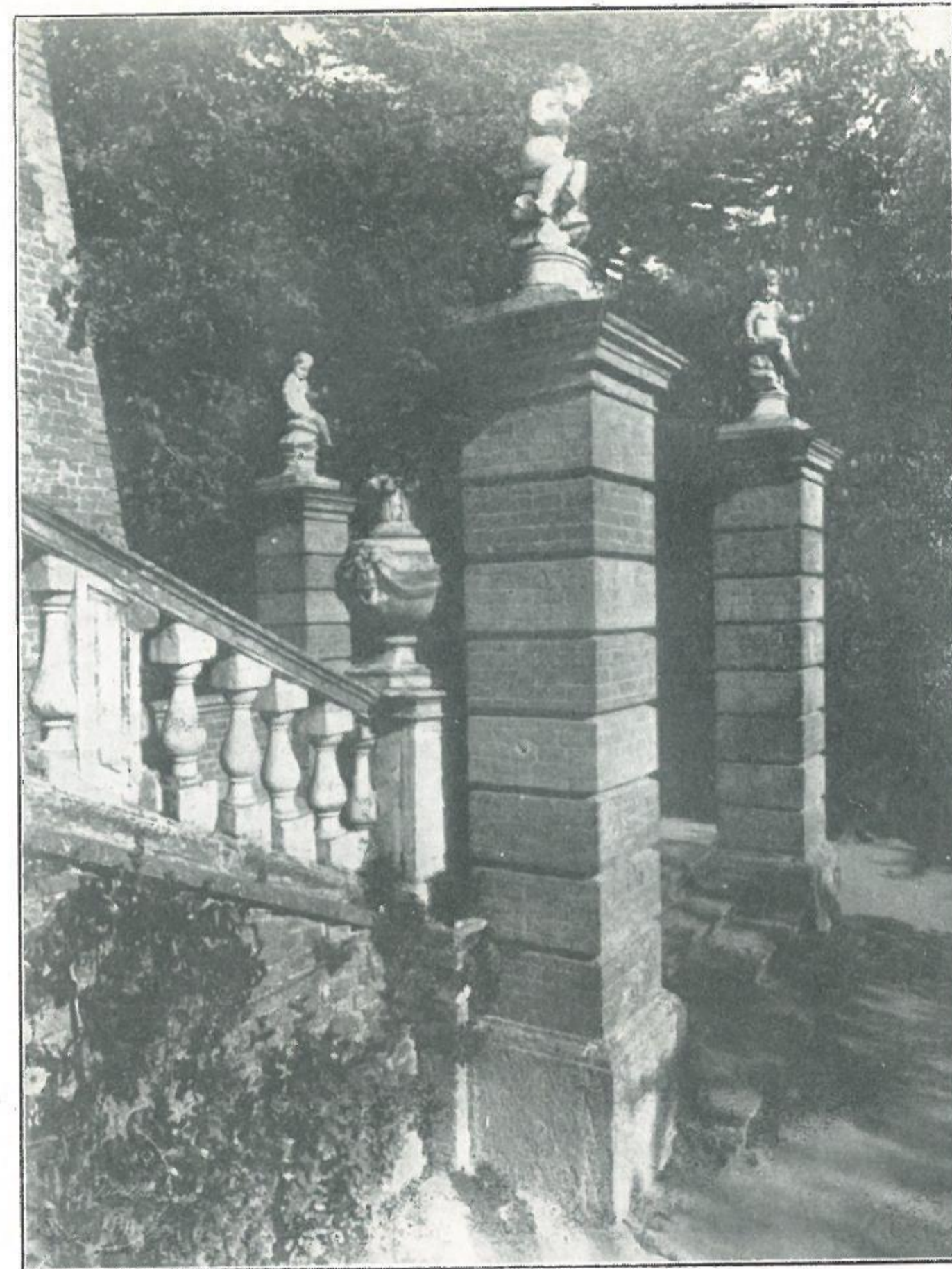
COVONE - Castello : Ingresso al parco
